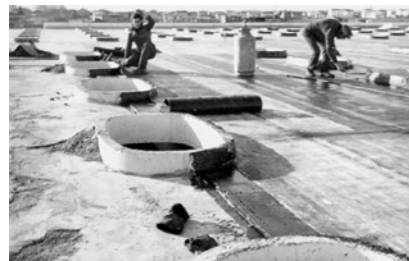
1974 UniFor inizia la costruzione della sua nuova sede a Turate (Como). Il progetto architettonico è affidato ad Angelo Mangiarotti.
